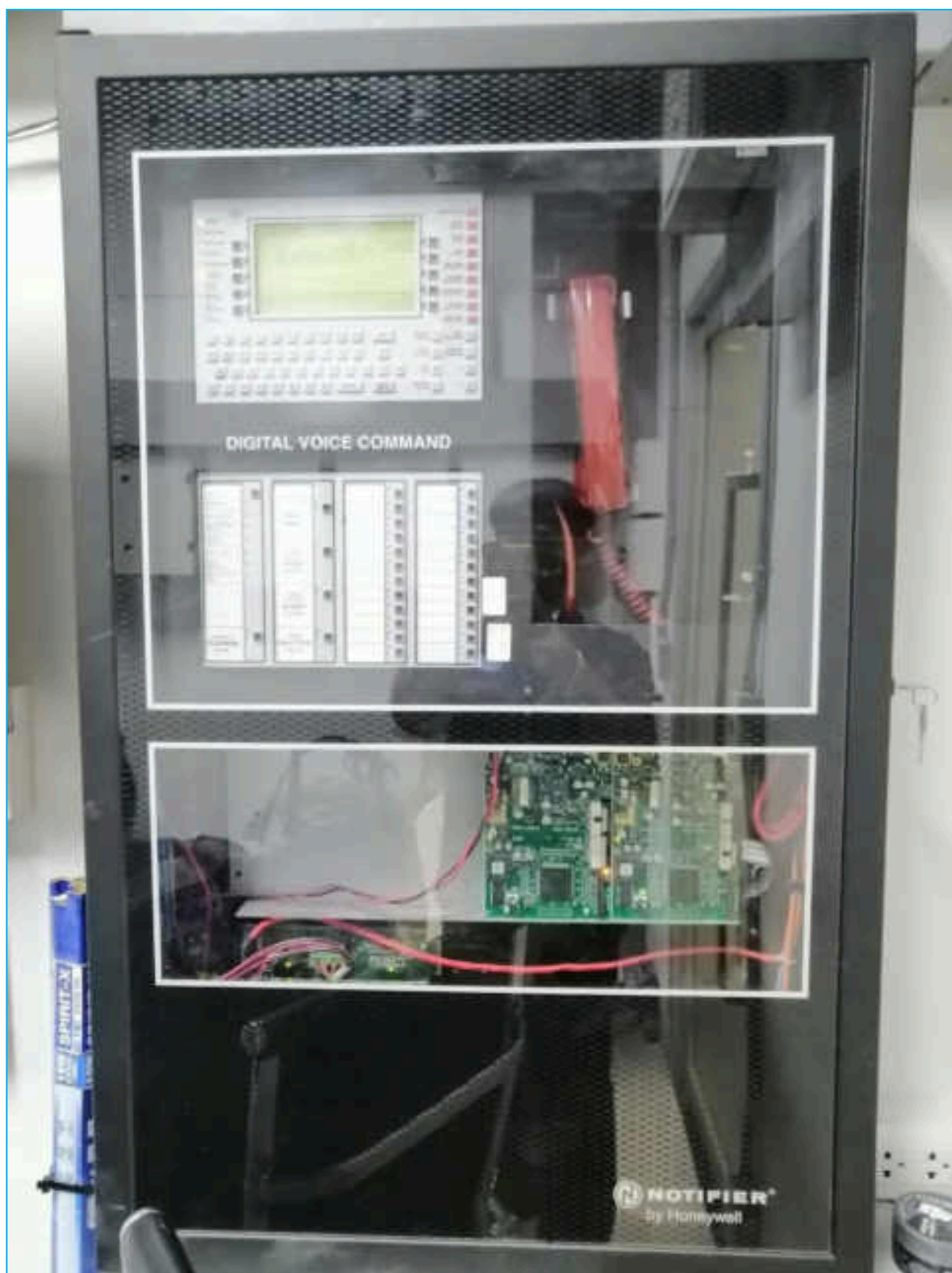
ภาพที่ 2-4(4.5-6) ระบบแจ้งเหตุเพลิงไหม้ตู้ FCP
