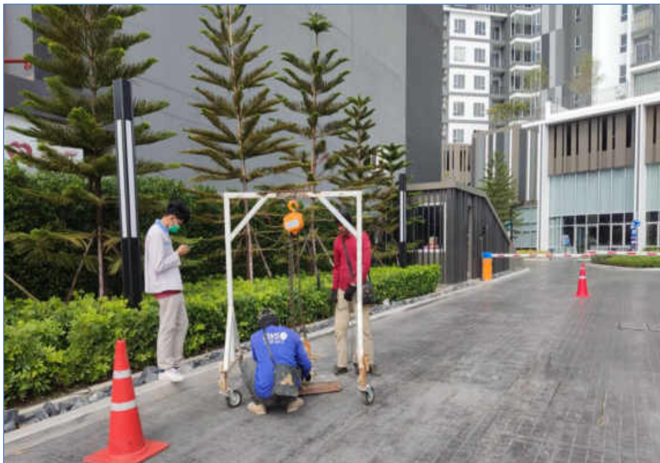
ภาพที่ 3-2(2.1) ช่างอาคารตรวจสอบท่อพักน้ำเดือนละ 1 ครั้ง ถ้ามีตะกอนให้สูบตะกอนทิ้ง (ต่อ)
