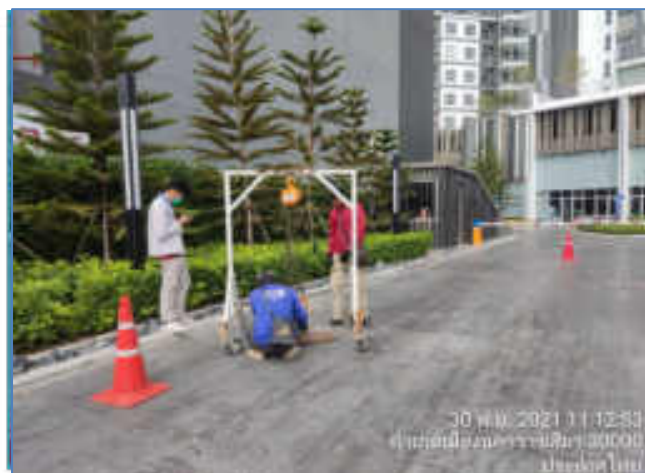
ภาพที่ 2-3(3.3-2) ช่างอาคารตรวจเช็คและบำรุงรักษา ระบบบำบัดน้ำเสีย
