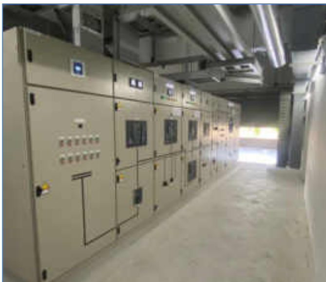
ภาพที่ 3-8(8.2) ช่างอาคารตรวจเช็ค ห้อง MDB ทุกวัน และ test run ระบบทุกวันพุธ เวลา 10.00 น. ประมาณ 15 นาที
